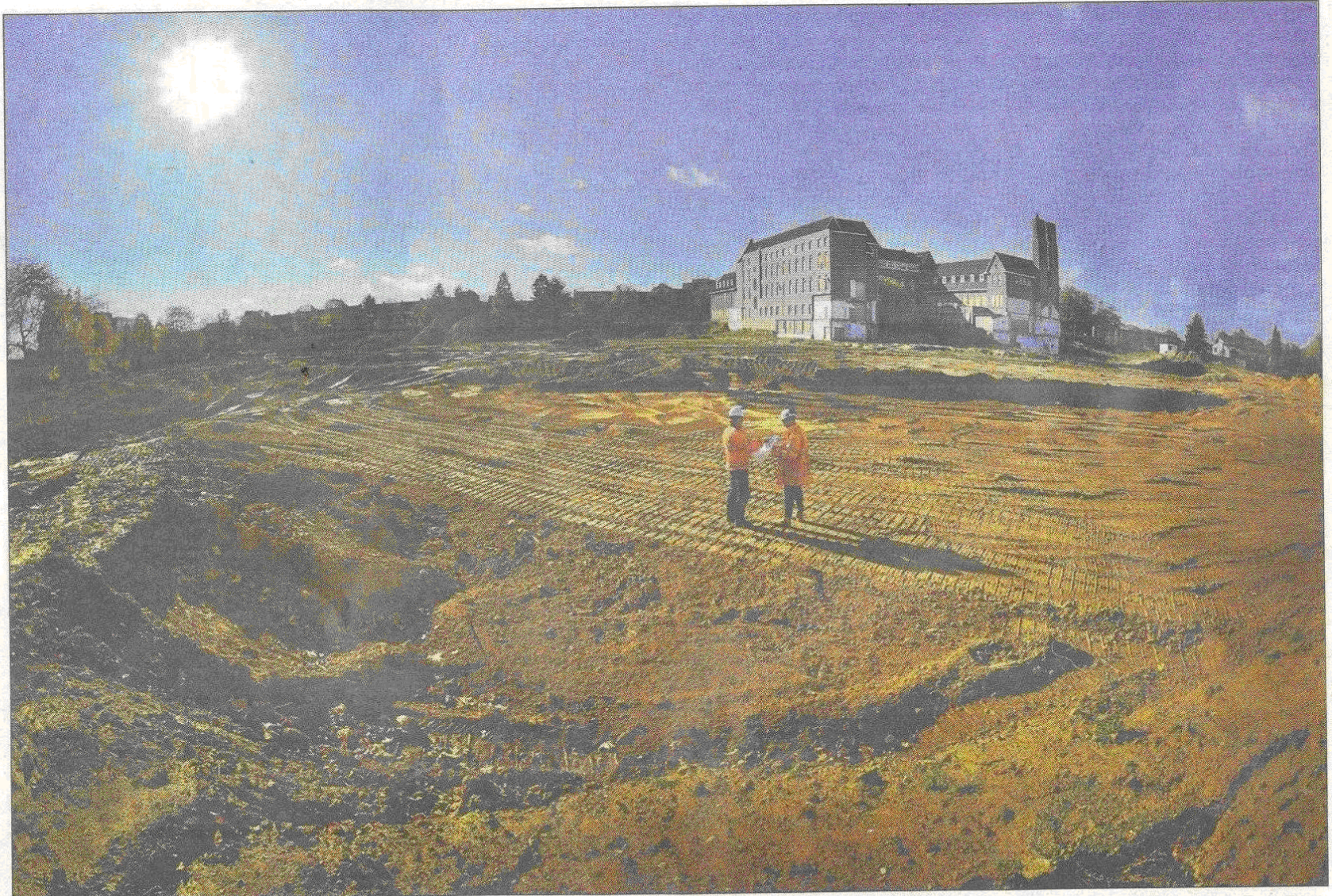
Het terrein van het gesloopte Maaslandziekenhuis in het centrum van Sittard, met op de achtergrond het Frans Klooster.
